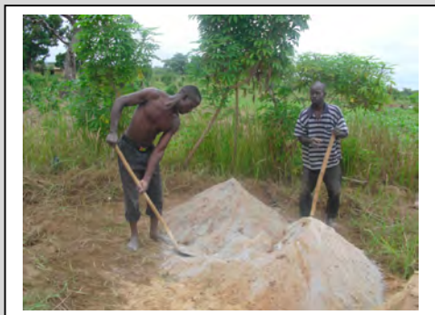
La fabrication des parpaings
