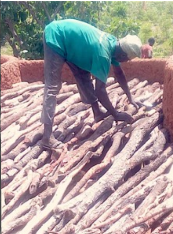
Alphonse prépare les bois de la terrasse avant de couler la dalle avec le banco.
